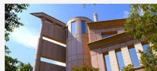
Building 3 - Av. Esplugues
